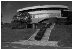
流水館の外観
